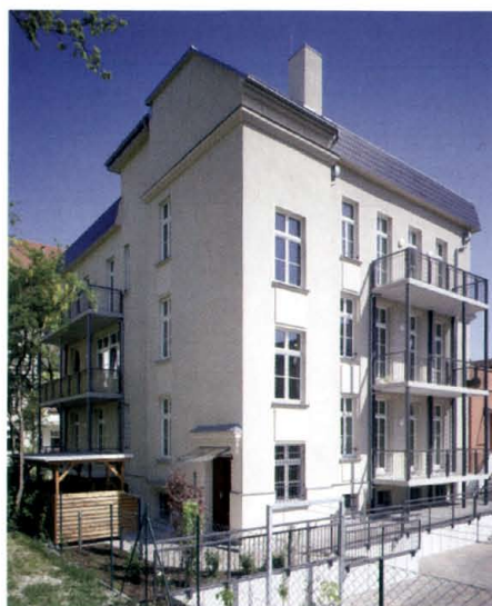
Das sanierte Gartenhaus (Umnutzung des ehemaligen Büro- und Verwaltungsgebäudes)
