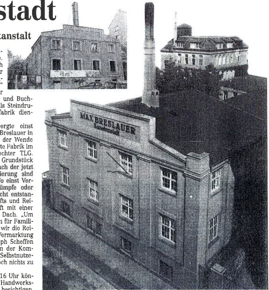
Ihren historischen Schriftzug – hier ein Foto von 1927 – soll die Kunstanstalt Max Breslauer bald zurückerhalten. In der Fichtestraße starten jetzt die Arbeiten (kleines Bild).
